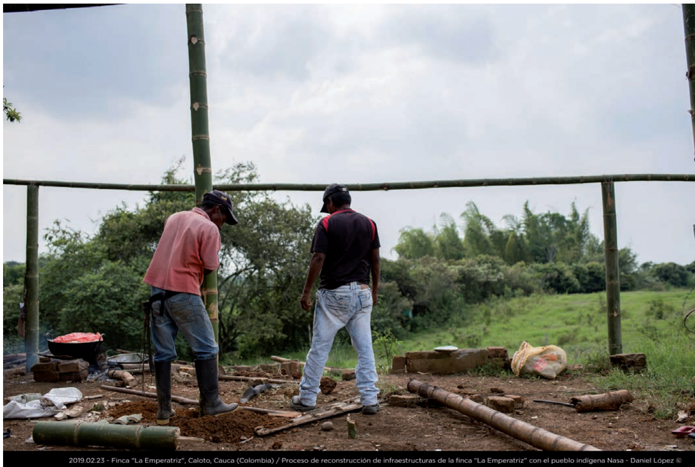
2019.02.23 · Finca "La Emperatriz", Caloto, Cauca (Colombia) / Proceso de reconstrucción de infraestructuras de la finca "La Emperatriz" con el pueblo indígena Nasa · Daniel López ©
